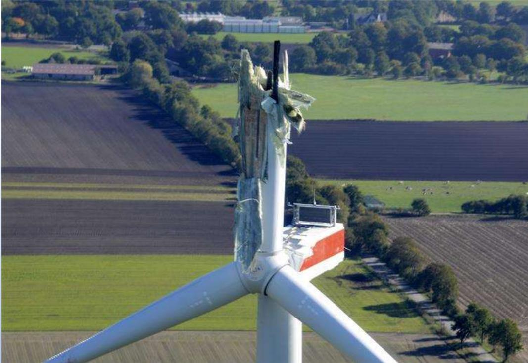
Erst knickte am 15.09.2022 das Rotorblatt einer Windenergieanlage im Windpark Alfstedt ab. Am 29.09. riss es komplett ab. Die Bruchstelle ist groß, **aus ihr gelangen seit Monaten feinste Kunststofffasern und auch größere Teile in die Umgebung.**
